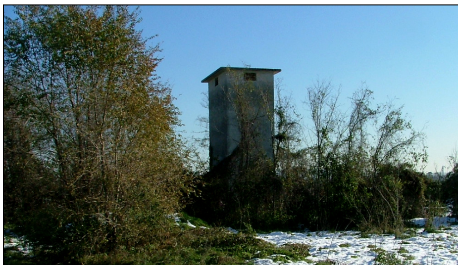
Cabina di trasformazione in disuso con specie cosmopolite di contorno (robinia)
