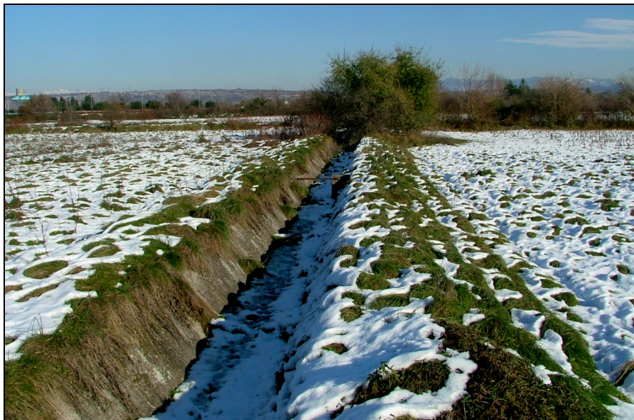
Canalizzazione del sistema di distribuzione irrigua a scorrimento
