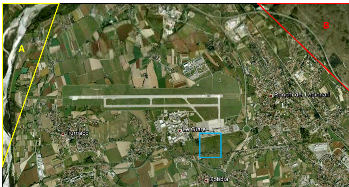
Ortofoto con indicazione degli elementi di cornice dell'ambito oggetto di analisi
