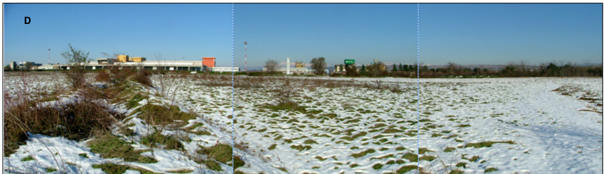
Vedute complessive dello stato dei luoghi con una canaletta irrigua in disuso e sullo sfondo il complesso aereo portuale
